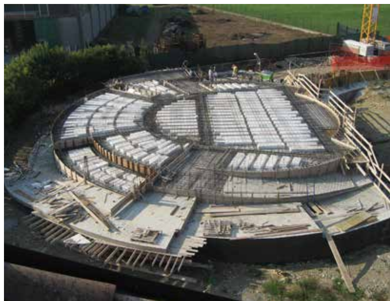
Il cantiere: esecuzione dei primi lavori
