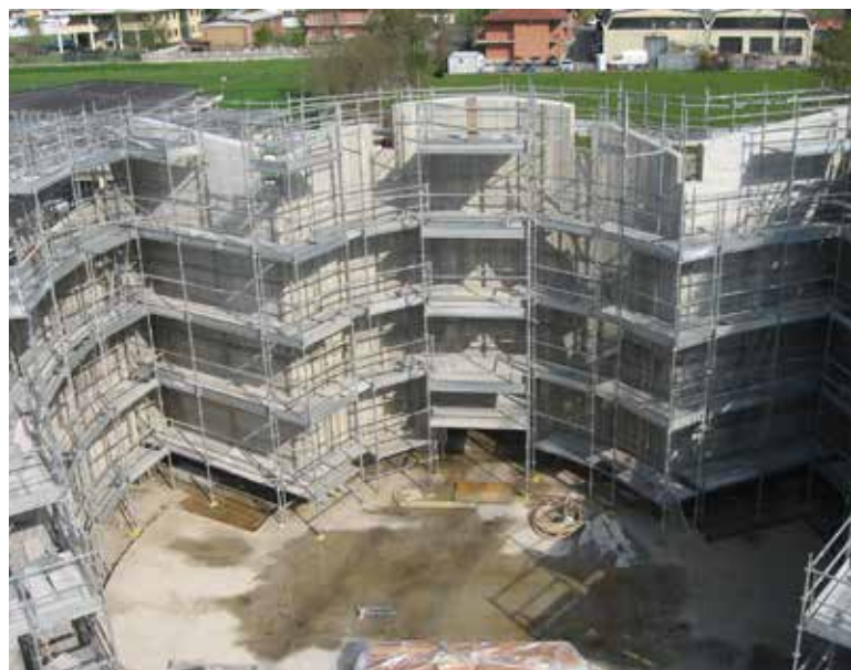
Il cantiere: costruzione delle pareti laterali
